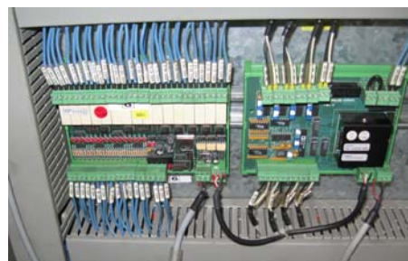
Schede di remotazione I/O che sono state eliminatee PLC S5 Valmet
