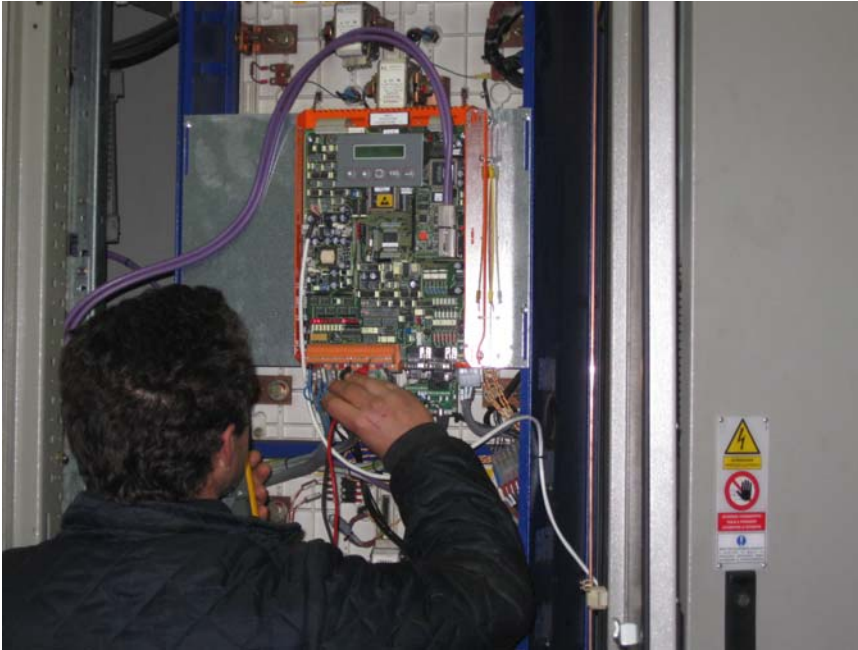
Test del rack reborn dopo il suo inserimento, Smurfit Kappa Ania.
