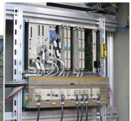
Schede di remotazione I/O che sono state eliminatee PLC S5 Valmet
