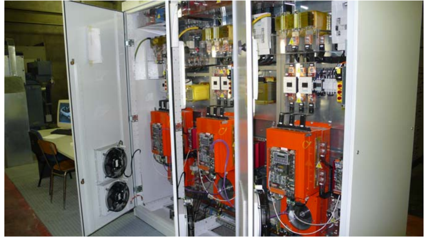
SX: primo rotolo avvolto con curve ricavate dai rilievi precedenti SOPRA: quadro elettrico drive cablato su 2 fronti per limitare gli spazi
