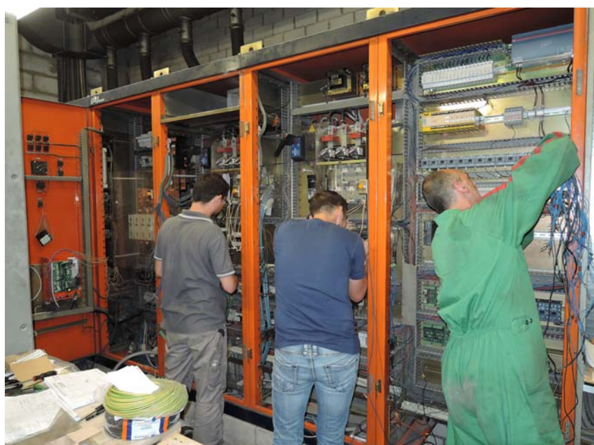
Durante le operazioni di cablaggio recupero quadro con REEBORN ONE
