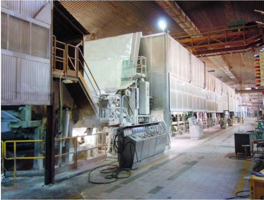
Vista zona SIZE della macchina 1 di Avezzano
