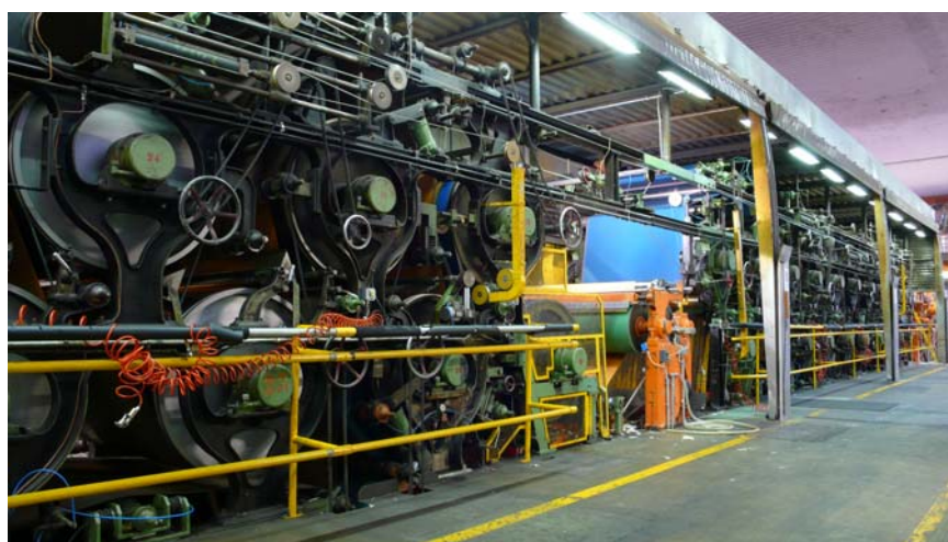
Veduta PM1 zona pope e seccherie-size, dove è stato eliminato il comando monoalbero e applicati i nuovi sezionali AC.
