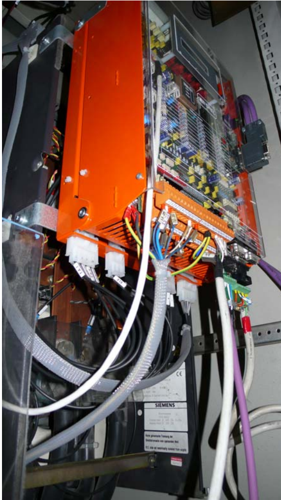
Esempio di riutilizzo del Drive Siemens 6RA24 con REBORN, sulla VARIDUR
