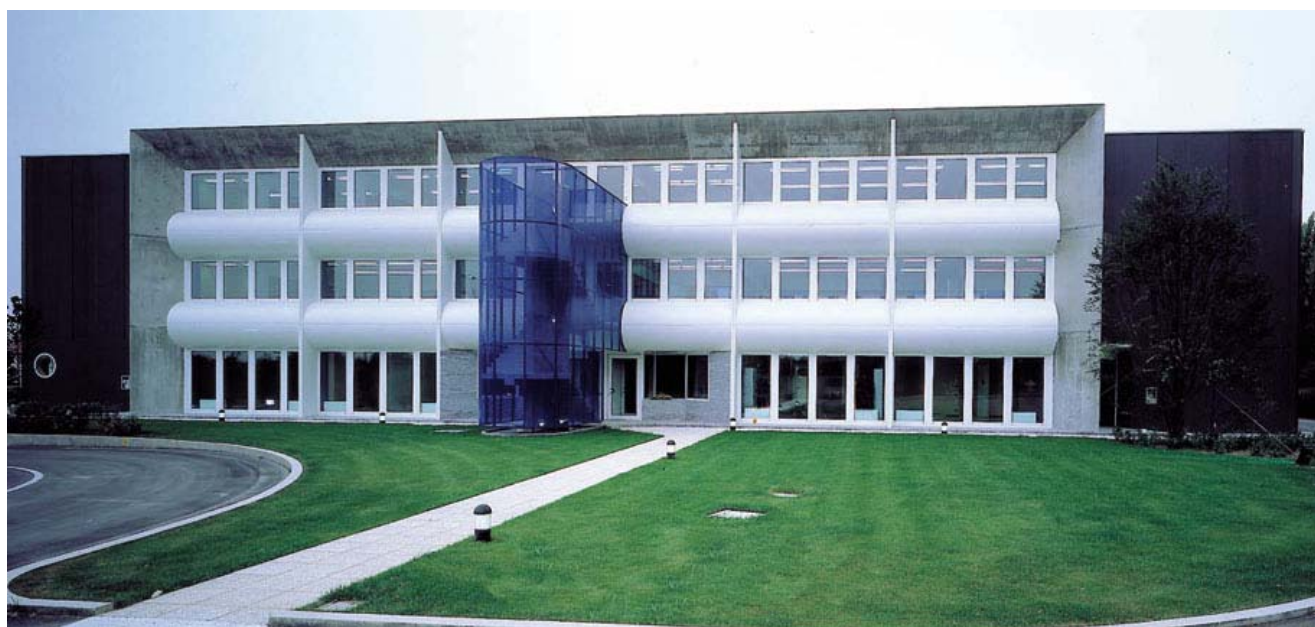
Veduta degli uffici centrali Favini Cartiere di Rossano Veneto (VI)
