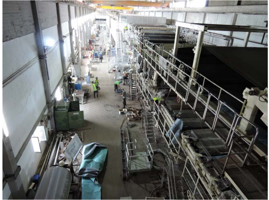
VISTA DELLA CARTIERA DURANTE LE FASI DI RICOSTRUZIONE
