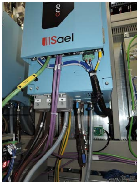
Particolare degli inverters serie WATER COOLING, serie esclusiva "PLATFORM ONE" di SAEL
