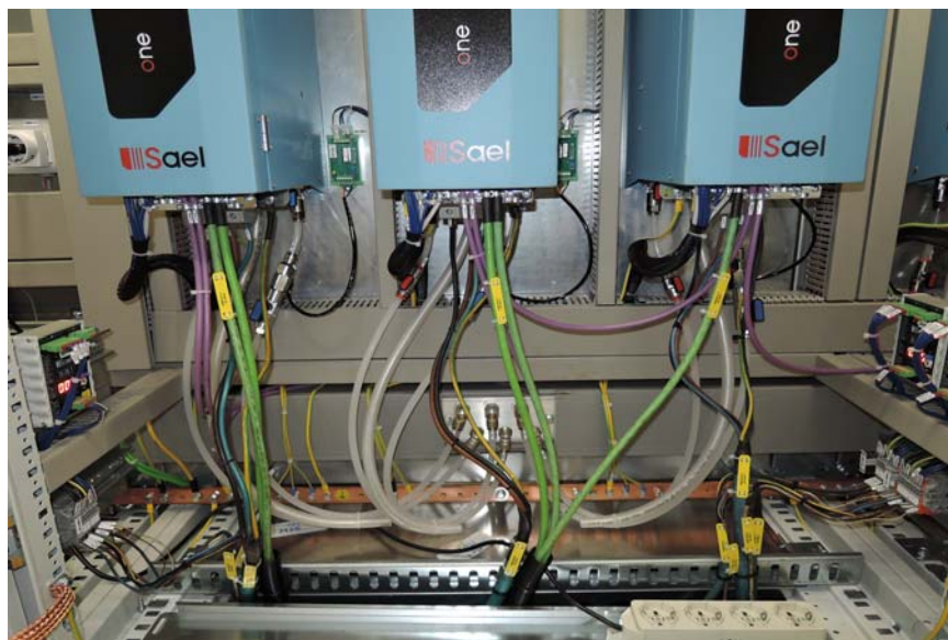
Particolare degli inverters serie WATER COOLING, serie esclusiva "PLATFORM ONE" di SAEL
