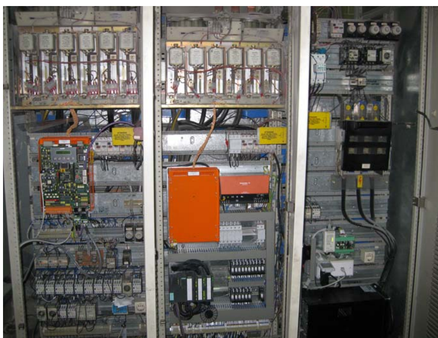
DRIVE SVOLGITORE ULTIMATO ED AVVIATO DOPO LA MODIFICA CON “REBORN”
