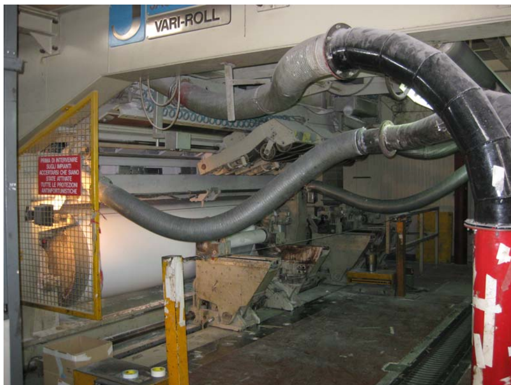
PRIMA LEVATA EFFETTUATA DOPO 4 GIORNATE DI AVVIAMENTO
