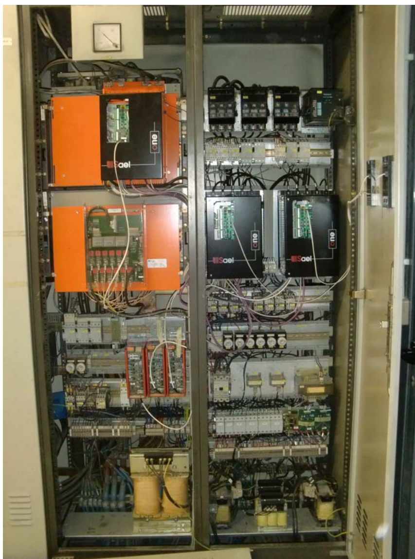
REBORN applicato sugli azionamenti Siemens, il primo step effettuato per sostituire il sistema Simadyn, SAEL Intelligent Drive
