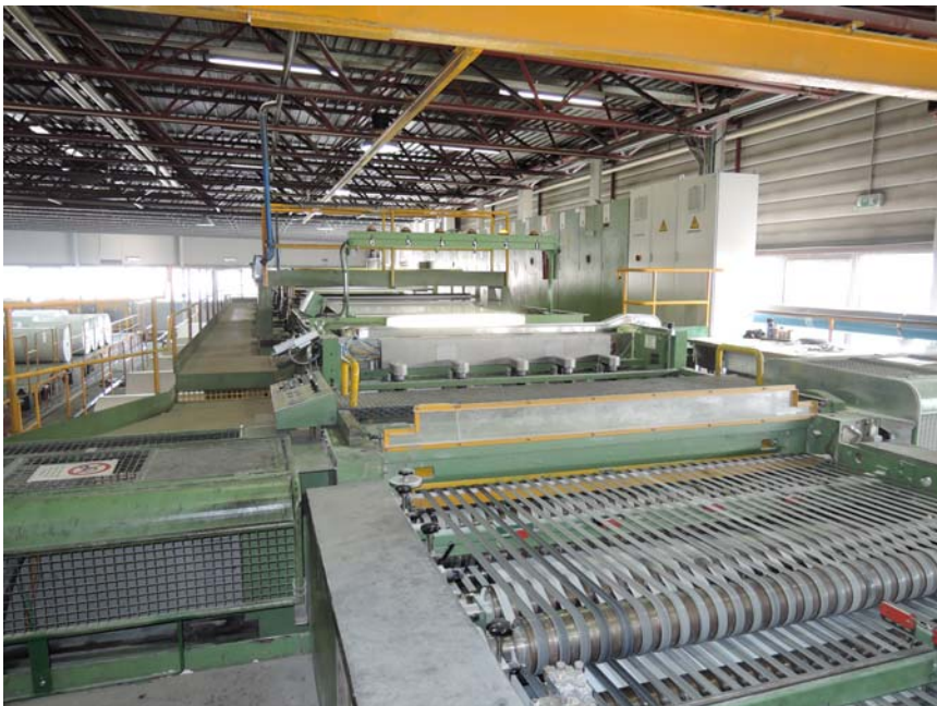
Bielomatik LECTA Garda, ricostruzione globale della taglierina; espianto del vecchio plc S5, dei motori DC con nuovi AC, sensori e automazione.
