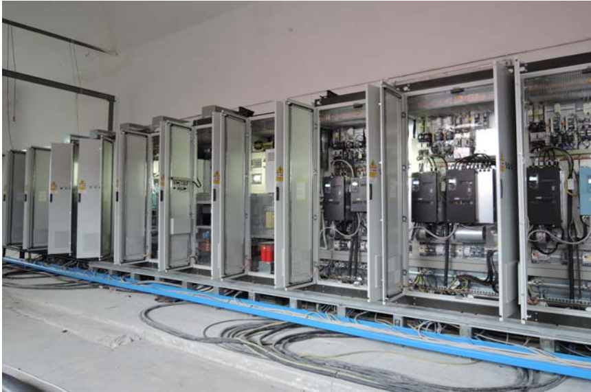
QUADRO di comando macchina continua 1 Fedrigoni, Verona
