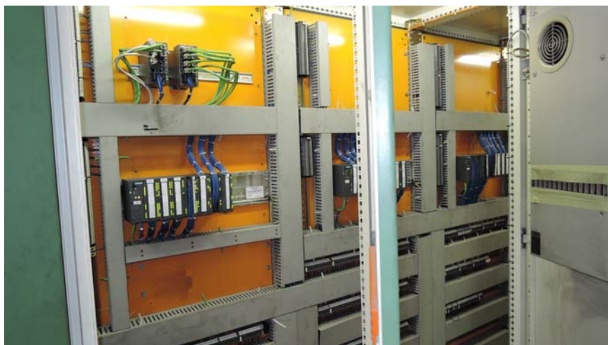
SOPRA: Il PLC S7300 usato per l'applicazione ricablato al posto del vecchio 115U
