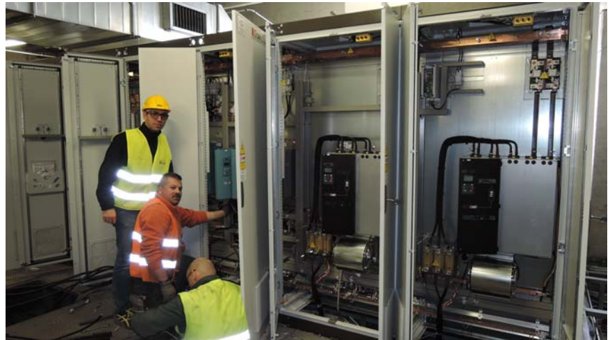
SX: nuovi motori AC al posto dei vecchi DC dopo la trasformazione- ALTO: durante i cablaggi dei quadri DRIVE, recuperati i vecchi quadri-
