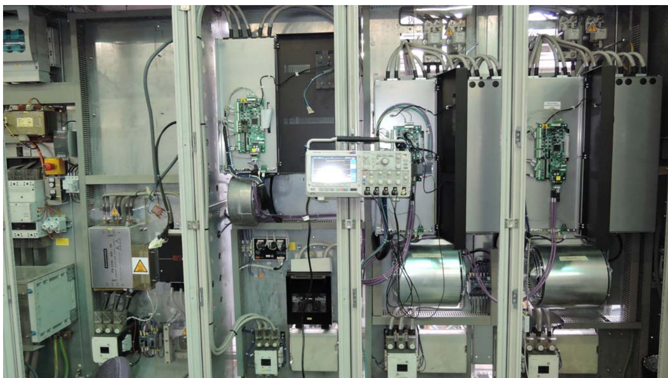
Quadro elettrico Jagemberg Synchro new generation dopo il rifacimento, Burgo Group Sarego
