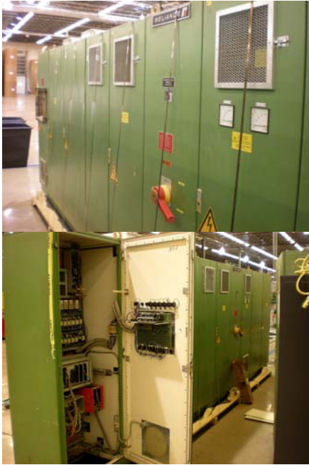
SX: quadri che hanno subito il riarmodernamento; DX: quadri riarmodernati con “intelligent drive SAEL”
