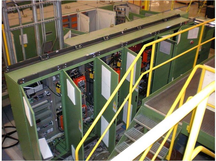
SX: quadri che hanno subito il riarmodernamento; DX: quadri riarmodernati con “intelligent drive SAEL”
