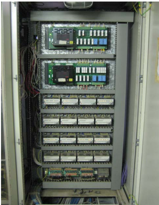
VECCHIO SISTEMA ABB SOSTITUITO CON IL NUOVO PLC VIPA (foto a dx), SISTEMA "EASY STOCK" SAEL
