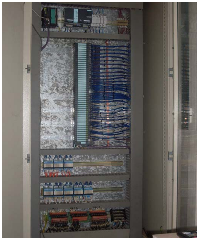
VECCHIO SISTEMA ABB SOSTITUITO CON IL NUOVO PLC VIPA (foto a dx), SISTEMA "EASY STOCK" SAEL
