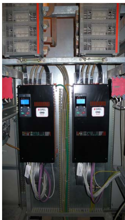
Vista del quadro su cui sono stati sostituiti i vecchi inverters con i nuovi della piattaforma “ONE DRIVE”
