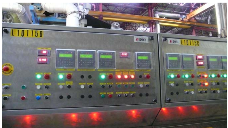
Una sezione dei nuovi quadri forniti per la zona umida e i pulpiti di comando preparati e gestiti dalla cartiera.
