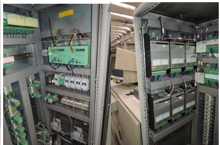
Da sopra: Rack Micromatik, elettrovalvole interbus, Azionamenti Micromatik sostituiti e tutta l'elettronica Interbus eliminata con ricablaggio di ET 200 Siemens.
