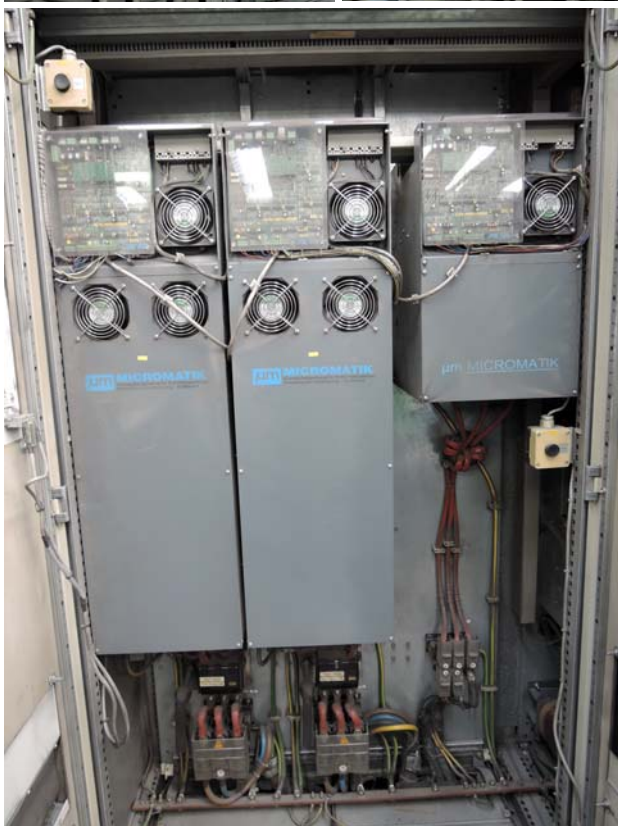
Da sopra: Rack Micromatik, elettrovalvole interbus, Azionamenti Micromatik sostituiti e tutta l'elettronica Interbus eliminata con ricablaggio di ET 200 Siemens.
