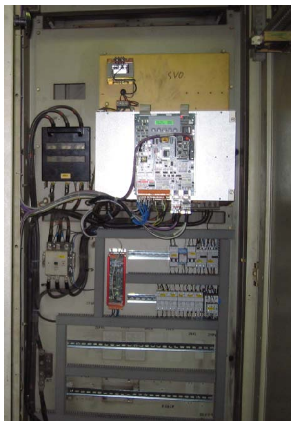
Drive DC esistenti in cartiera prima e dopo la trasformazione con REBORN
