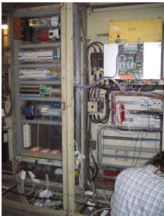
Operazioni di ricablaggio vecchio quadro esistente in cartiera, dic. 2006
