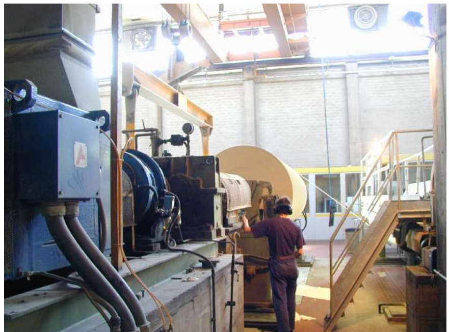
Rifacimento ribobinatrice SDW stabilimento di Villorba, Burgo Group
