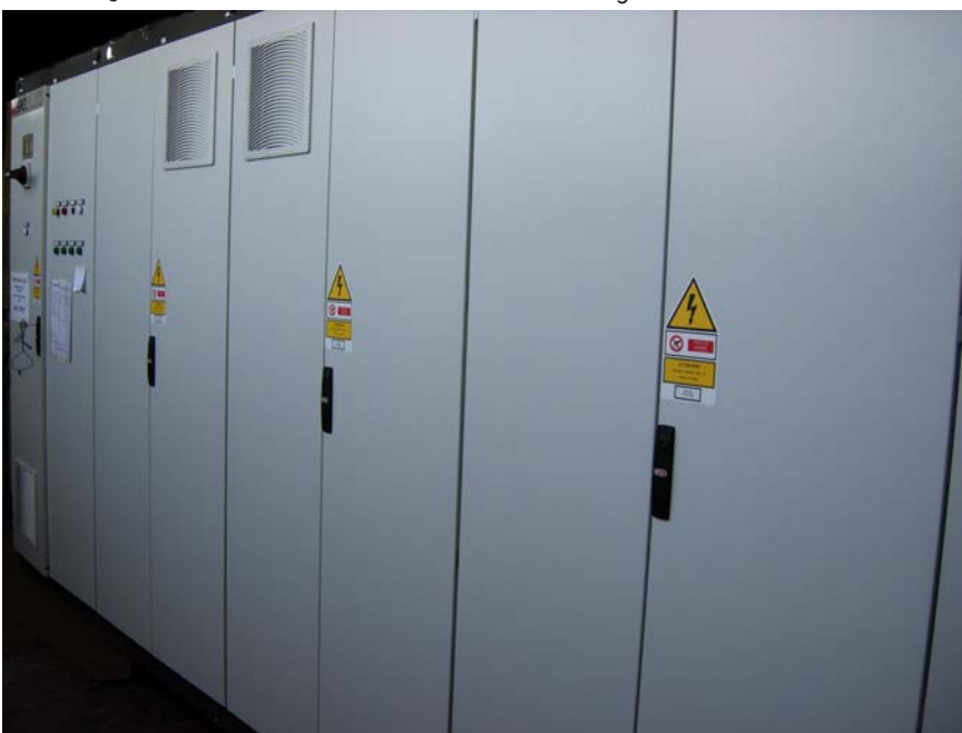
NUOVO QUADRO CHE SOSTITUISCE TUTTA LA PARTE ELETTROMECCANICA
