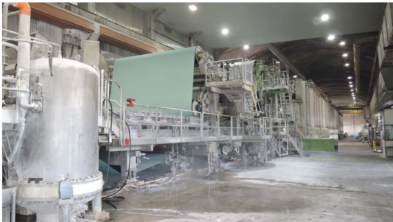
Vista zona umida MC1 stabilimento di TOLMEZZO ricostruita con PLATFORM ONE DRIVE
